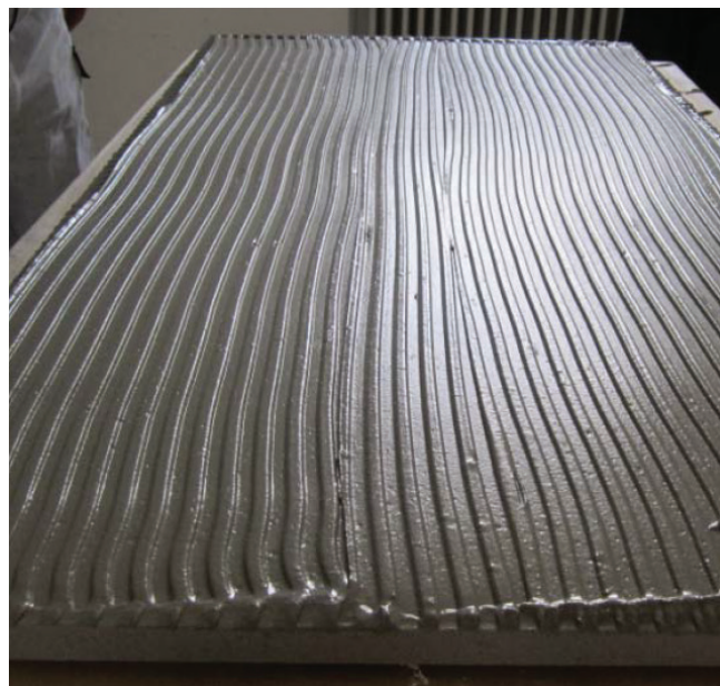
Sposób nakładania masy StoDeco Coll
